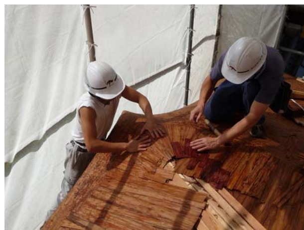
重要文化財直会殿の栓皮屋根葺替
